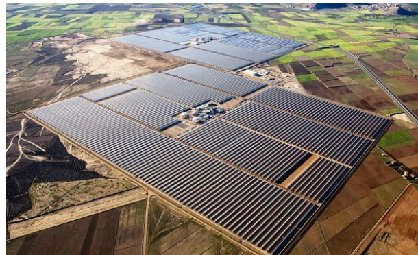
Figure 13 : Centrale ANDASOL 1 vue du ciel
