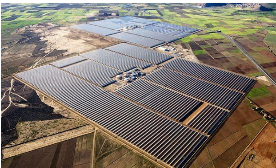
Figure 38 : Centrale Andasol 1 vue du ciel [2]
