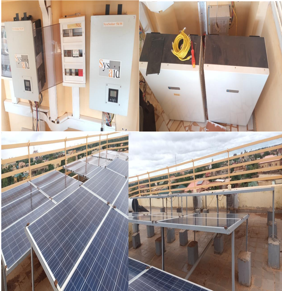
Figure 23: Maintenance dans un domicile à Ouagadougou
