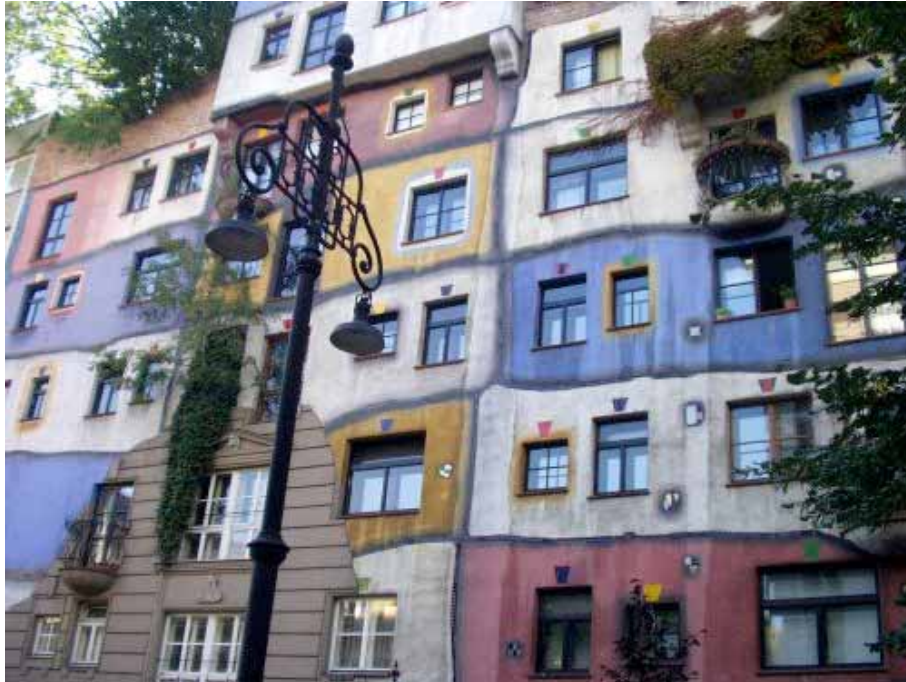
La Maison Hundertwasser (1990), Vienne : Autour des fenêtres , toute la surface que le bras peut être décoré à la guise de l'habitant.
