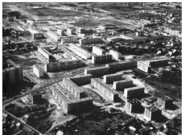
La Zup de Nantes-Saint-Herblain en cours de construction (1967).
