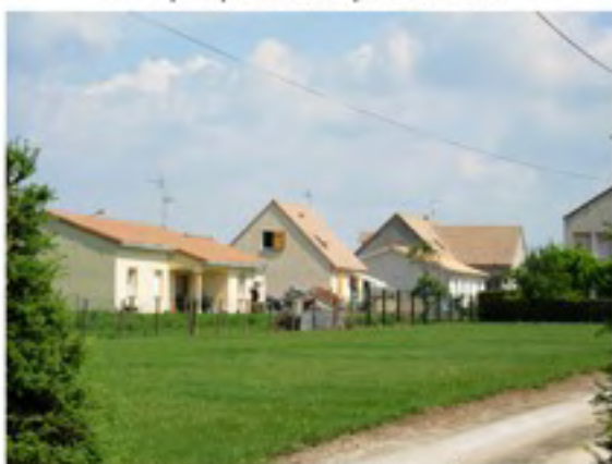
13 Le pavillonnaire récent
