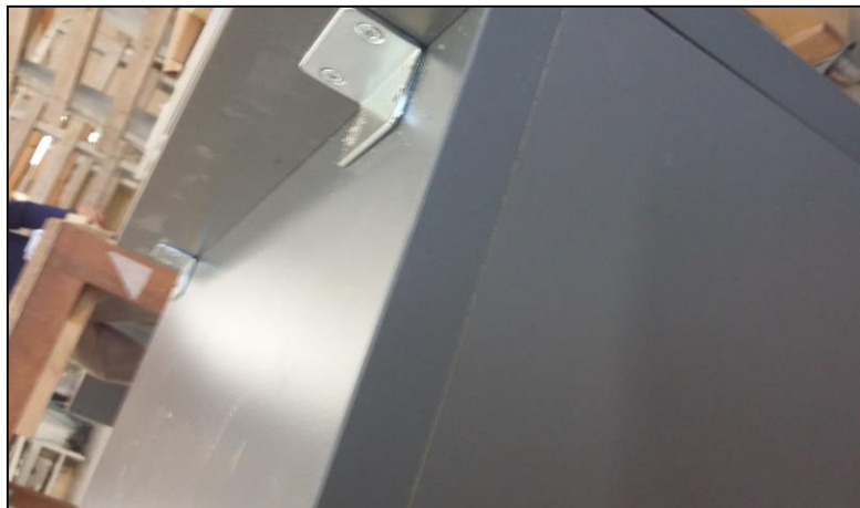
Fixation de la plinthe par les équerres.
