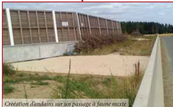
Création d'andains sur un passage à faune mixte
