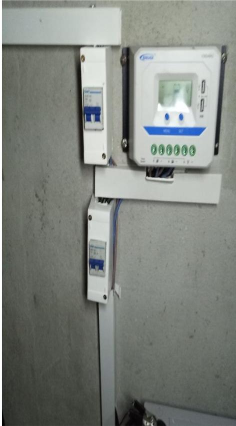
Figure 3: Régulateur de charge
